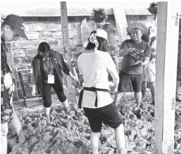
チトレでの泥壁造り
